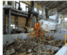
ピニアクレーンによる固形物の搬入
