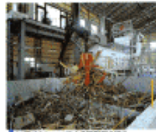
ピットクレーンによる固形物の搬入
