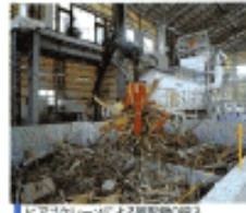
ピアシクレーンによる固形物の搬入
